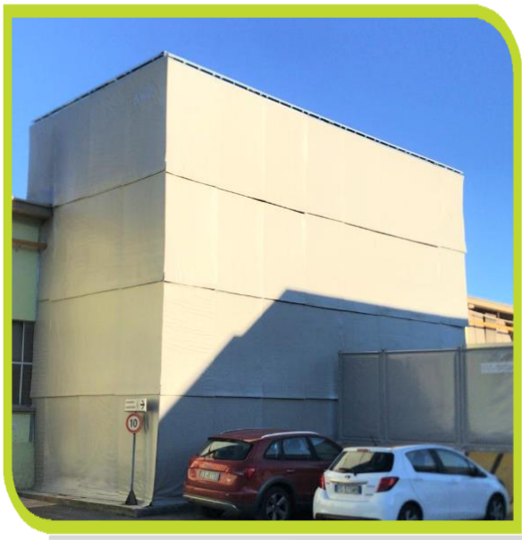
Schermature antirumore per impianto industriale
