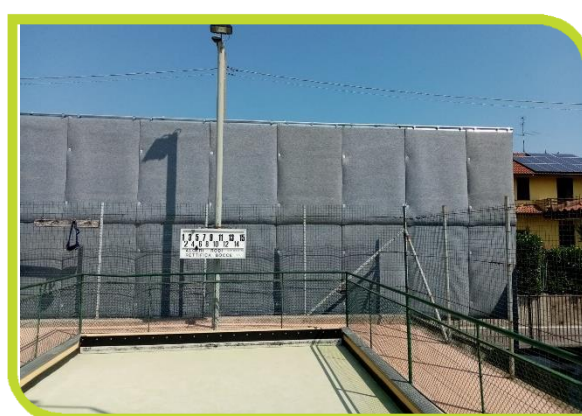
Schermatura presso una boccefila
